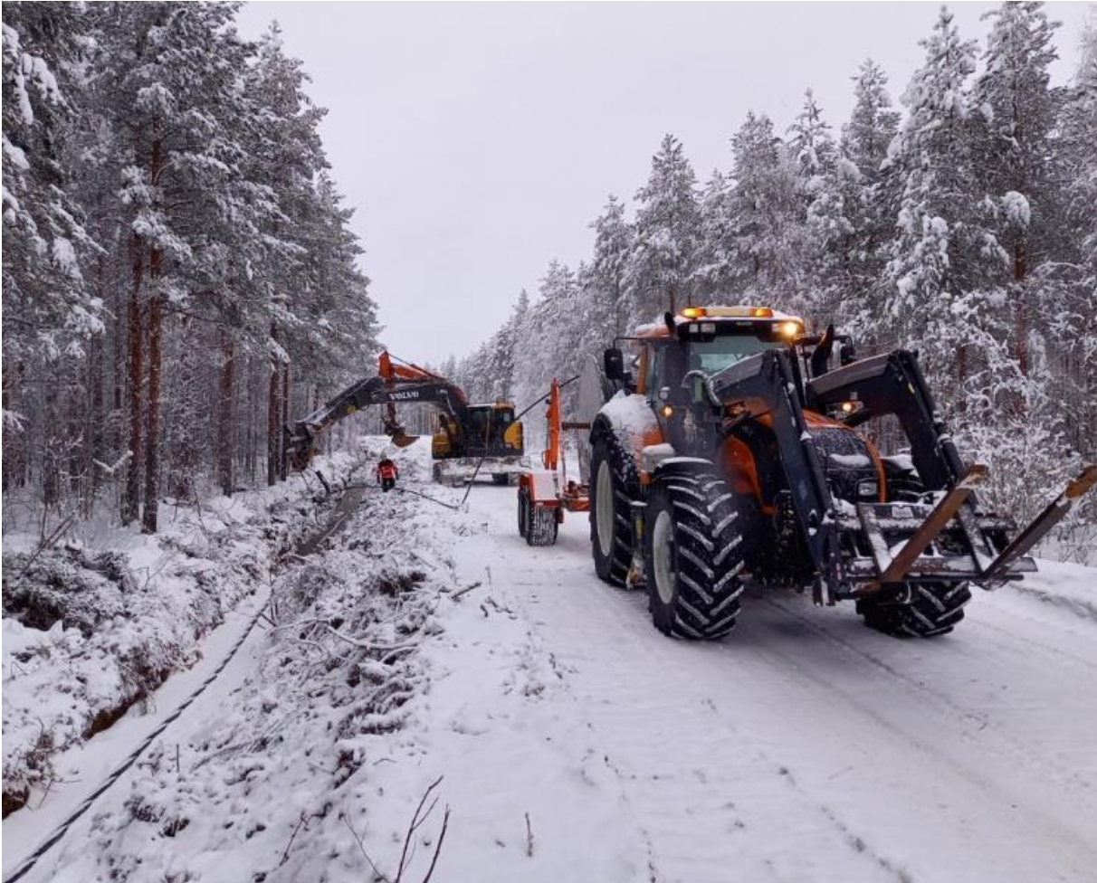
Kuva 3-5. Esimerkkutilanne kaapelin asentamisesta kaapeliojaan (Lähde: ABO Wind Oy).
