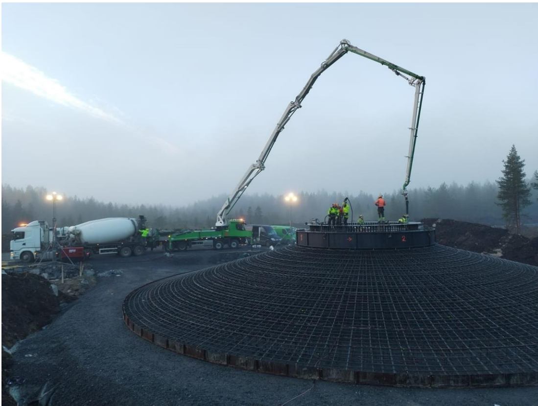
Kuva 3-3. Voimalan perustus (Lähde: ABO Wind Oy).
