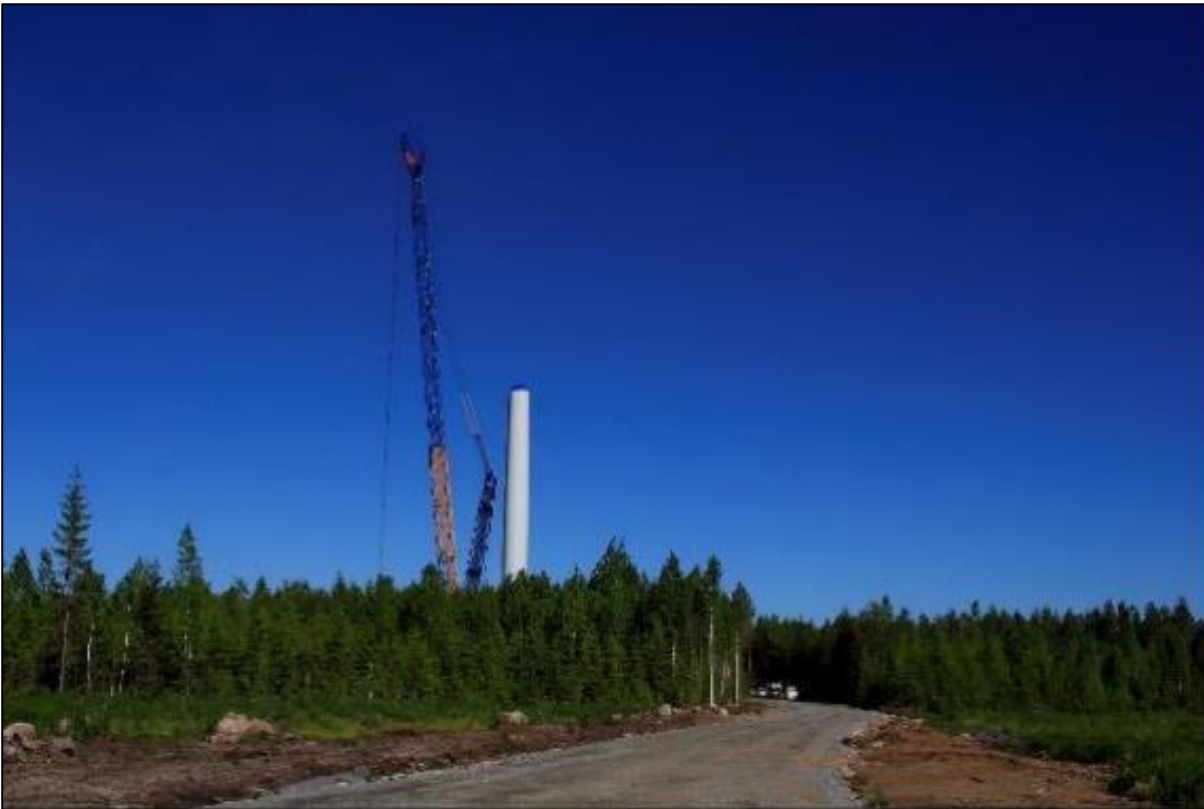
Kuva 3-14. Esimerkki tuulivoimalan tornin pystyttämisestä nosturilla (Lähde: Abo Wind Oy).
